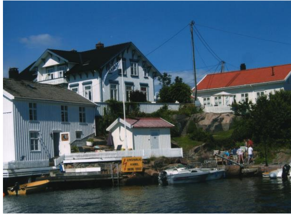
Stolpe og transformator 2007
