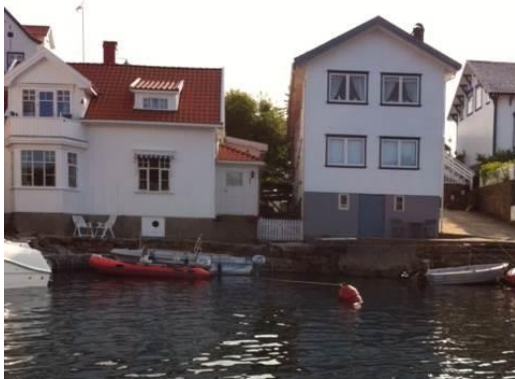
Sprekksonen sett fra vest
