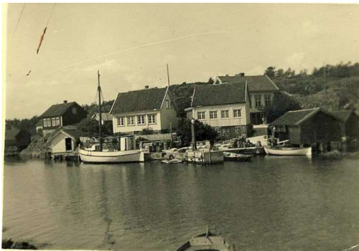
Løva på Klåholmen etter ombygging til reketrøler
